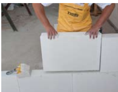
Murujemy kolejną warstwę pamiętając o przesunięciu spoin pionowych
