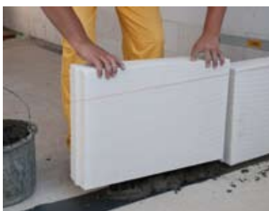
Dostawiamy kolejny bloczek, bez wypełniania spoin pionowych – zastępuje je system pióro-wpust
