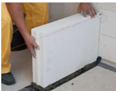
Pierwszą warstwę bloczków układamy na tradycyjnej zaprawie, pamiętając o izolacji przeciwwilgociowej
