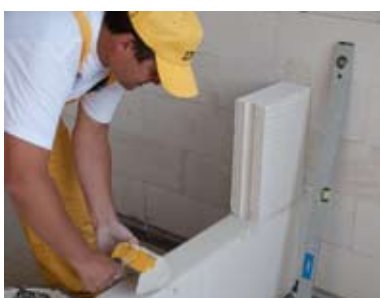
Zaprawę rozprowadzamy kielnią do cienkich spoin
