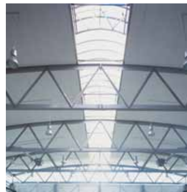
Hala zbudowana w systemie elementów zbrojonych YTONG, Niemcy
