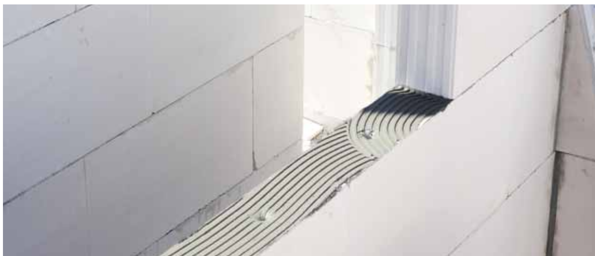
Zaprawę murarską na bloki SILKA TEMPO nanosi się kielnią do cienkich spoin
